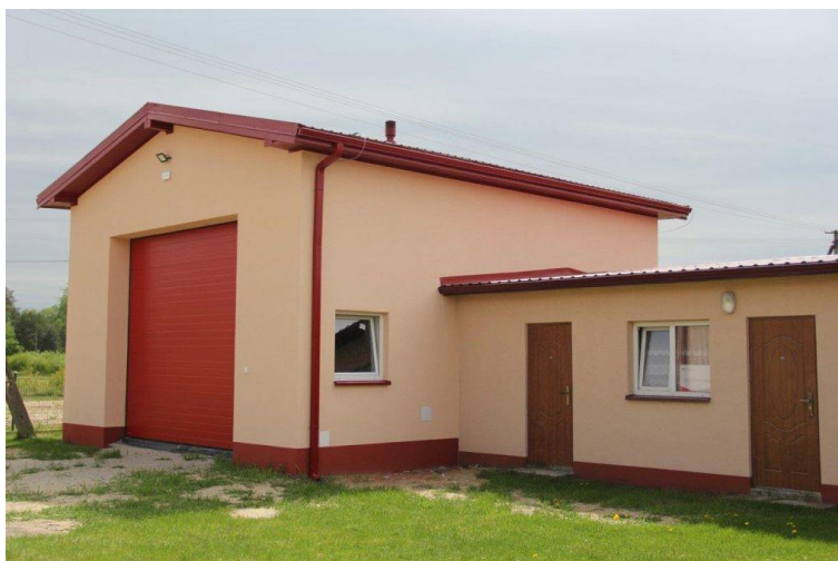
Zdj. 13 Przebudowane pomieszczenia gospodarcze przy remizie OSP w Hucisku
