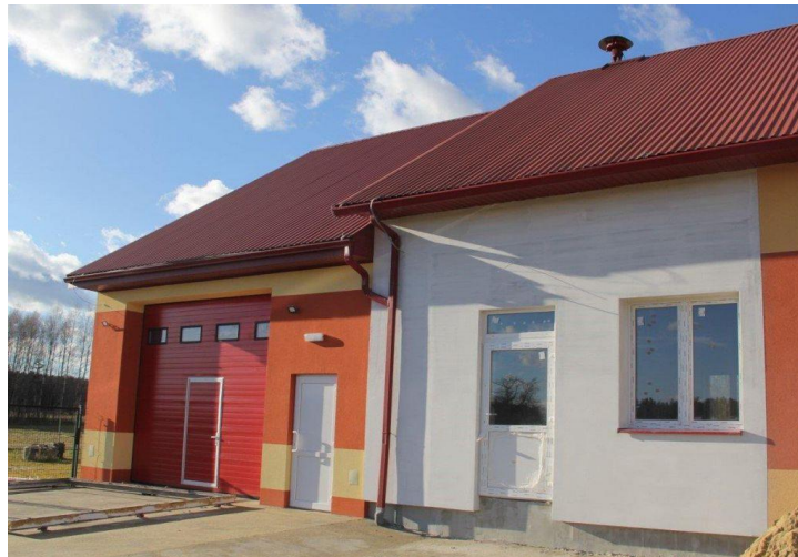
Zdj. 14 Rozbudowa budynku remizy OSP Zapole – pomieszczenie garażowe plus zmiana przeznaczenia pomieszczenia po garażu
