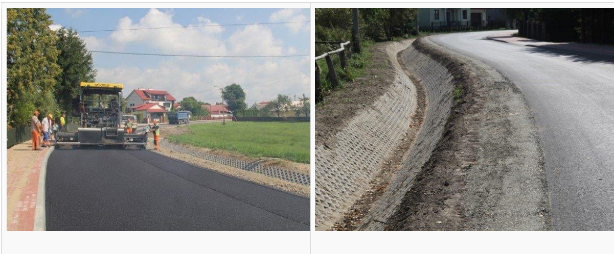
Zdj. 7, 8 przebudowa drogi gminnej nr 104157R wraz z budową chodnika
